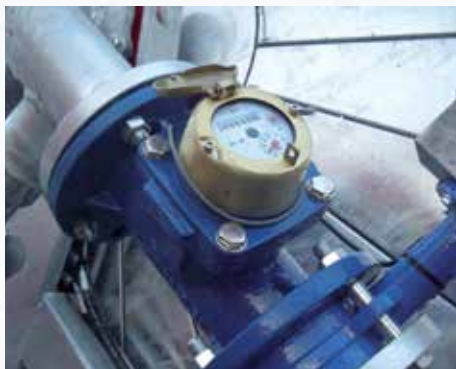
A tekercs bemenetére szerelt karimás literszámláló.
